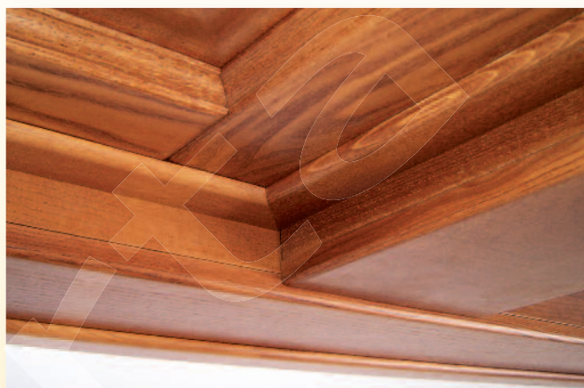
obklad stropu, masív
