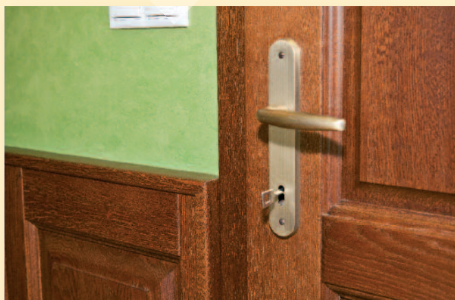
obklad - napojenie dverí
