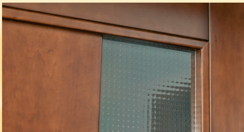
spojenie skla a kazety
