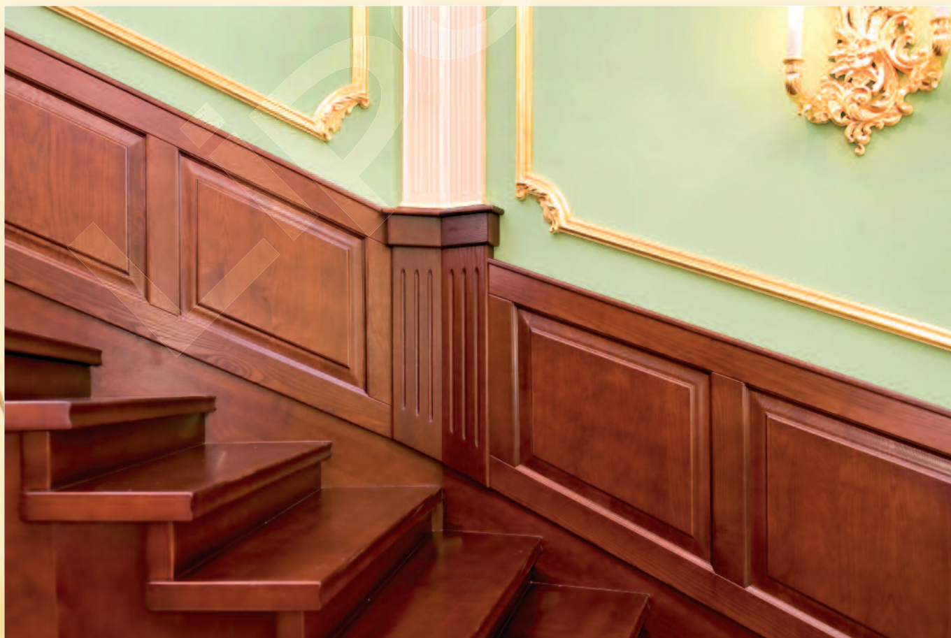
obklad schodiska, masív
