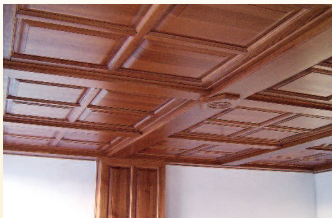
obklad stropu, masív
