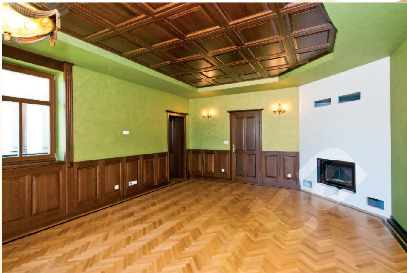
obklad stropu a stien, masív
